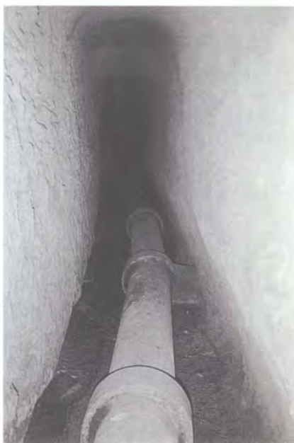
Mina de Les Fatjones-Torreblanca. La canonada de formigó instal·lada aquell mateix any.
