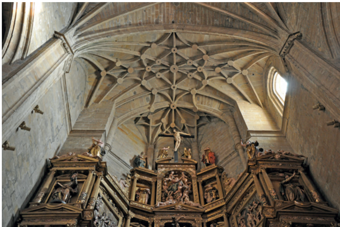
Figura 6. Iglesia de San Vicente. Bóveda de la cabecera. Foto: M. J. Tarifa.
