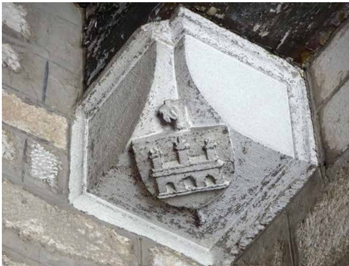
Figura 10. Ménsula (piedra armera). Pasillo del primer piso. Palacio Episcopal de Barcelona. Foto Barrachina.
