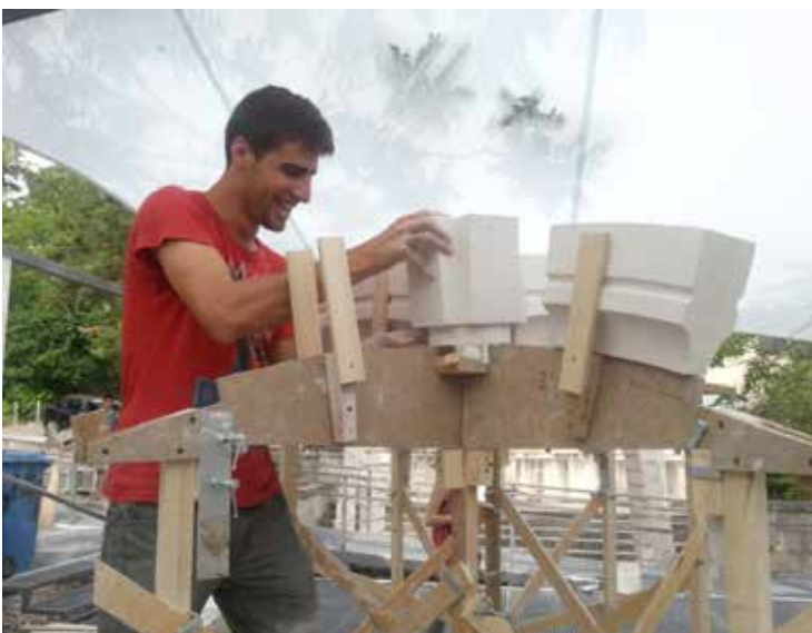
Figura 23. Colocación de las claves.
