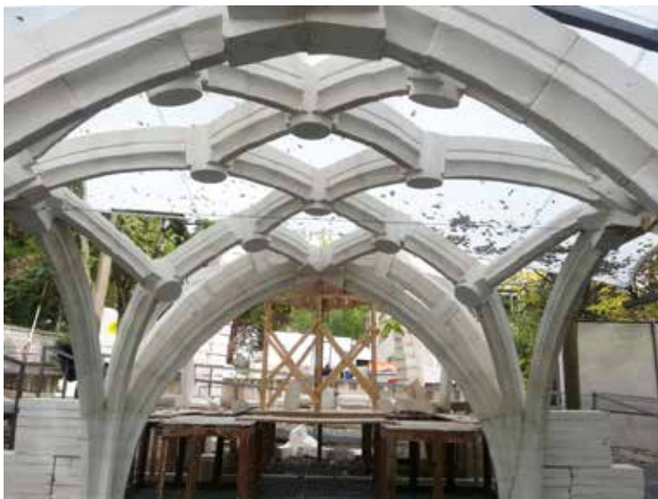
Figura 25. La bóveda en red de Ribes vista por su intradós.
