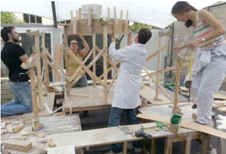
Figura 22. Colocación de los pies derechos que sujetarán las claves.
