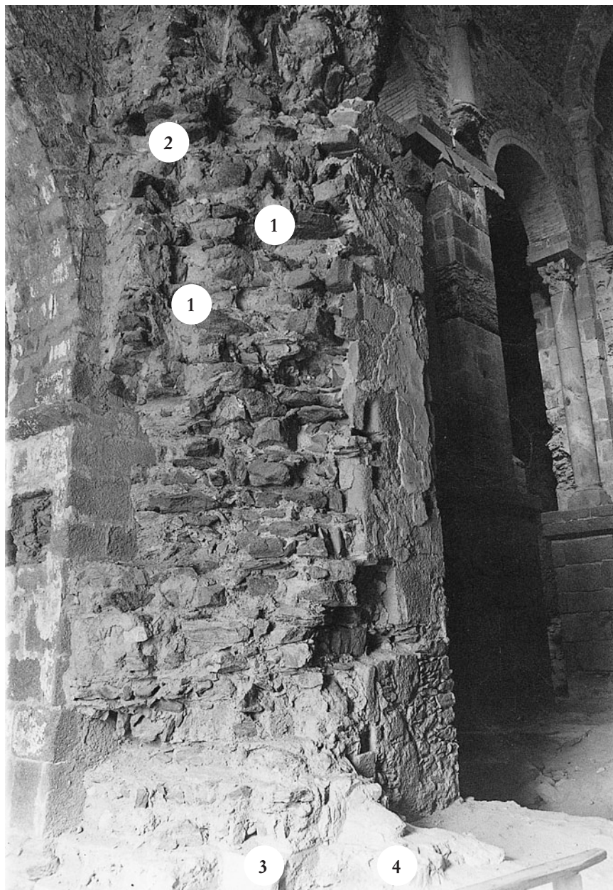
Figura 14. Mampostería de relleno de la portada del Maestro de Cabestany. 1. Rebajes verticales, seguramente donde iban los fustes de las columnas. 2. Perforaciones probablemente para insertar las impostas. 3. Umbral de la portada. 4. Mampostería del umbral.
