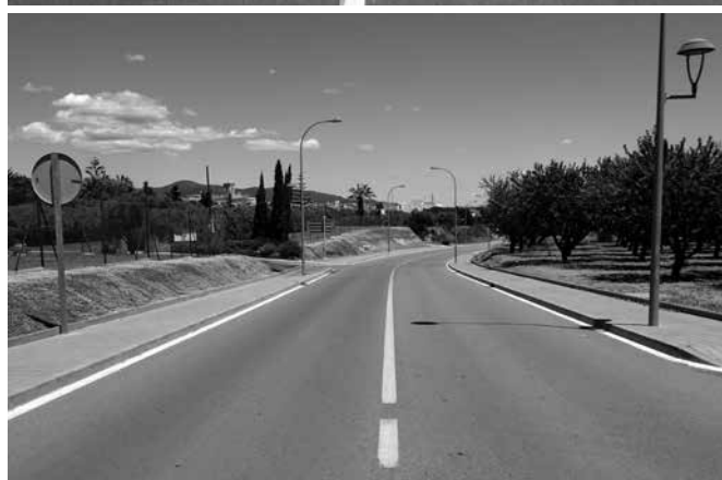
Fotos 8, 9 i 10. Exemples d'avingudes d'entrada al poble arbrades com la de Reus són el camí a seguir. Ara falta, com es veu a les altres dues fotografies, completar la feina a l'entrada per Vinyols i els Arcs i Montbrí del Camp.
