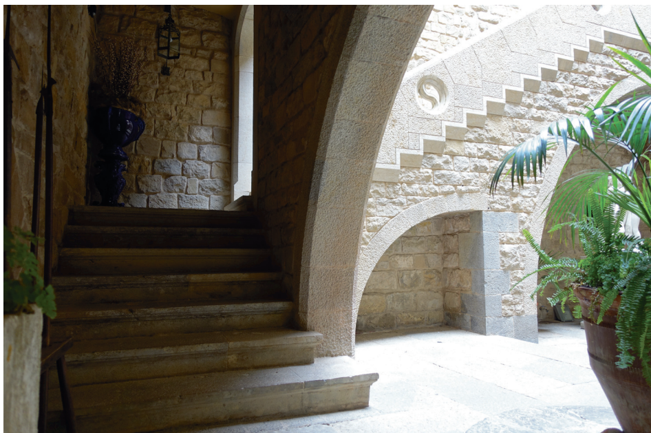
Primer tram cobert de l'escala del pati. El treball dels blocs de pedra marca diferents textures de relleu que no només singularitzen la barana, sinó que, sobretot, permeten diferenciar els murs nous que suporten l'escala, dels antics de les parets del fons. Foto Laia de Quintana.
