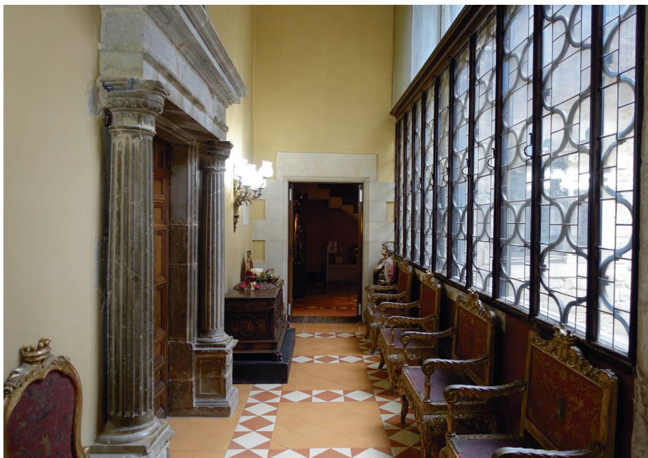
Tram tancat de la galeria gòtica. L'arquitecte va reconvertir l'antic vestíbul en un espai de circulació interna i el va ennoblir mitjançant unes vidrieres de forja adossades als arcs del tram de galeria gòtica i una portalada renaixentista, manlevada d'un altre edifici de Torroella, que dona accés al menjador. Foto Laia de Quintana.
