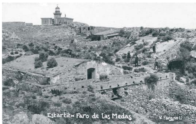
La Meda Gran. S'aprecien restes de construccions militars del període de la guerra del Francès i la cisterna d'aigua plujana per al subministrament a la guarnició. Foto V. Fargnoli (Fons Fotogràfic - Centre de Documentació del Montgrí, illes Medes i Baix Ter)
