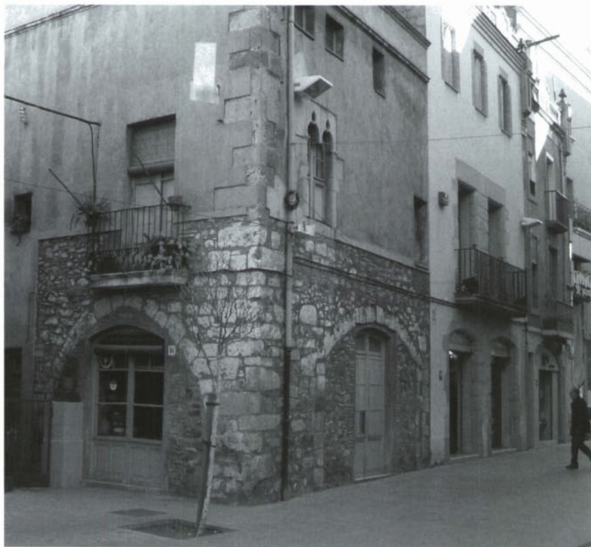
Doble arcada d'un cap de l'espai porticat que hi havia entre la plaça de l'Oli i la plaça de les Olles. Plaça dels Cabrits núm. 4, cantonada plaça de les Olles. (Fotografia: Pere Cornellas, gener 2002)
