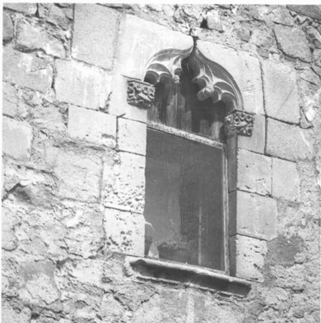
Detall de la finestra del primer pis de la torre.
