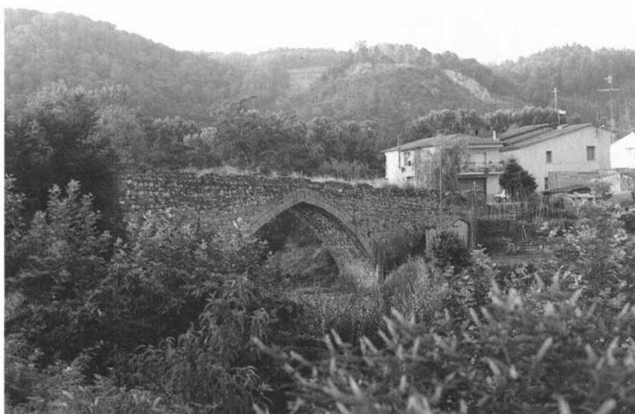
Pont Trencat (Sant Celoni). Projecte de rehabilitació finançat pels ajuntaments de Sant Celoni i Santa Maria de Palautordera, el Consell Comarcal del Vallès Oriental i la Unió Europea. Campanya 1998. (Fotografia: Estrat.)
