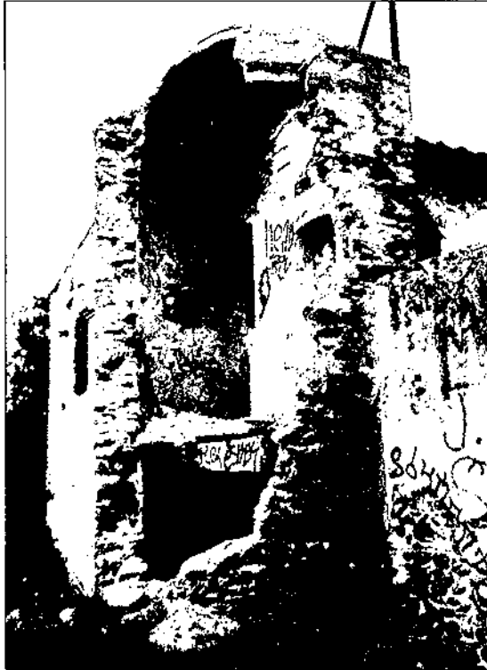
Torrí. Exemple del deplorable estat actual del mas. Fotografia: J. Raurell
