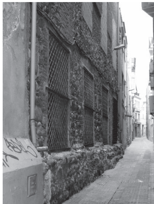
Extrem de ponent del carrer de la Constància, on encara s'observen trams de la muralla integrats en els immobles actuals. (Fotografia: autors, 2005)
