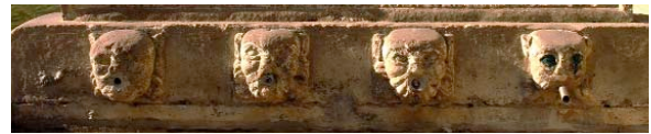
Les canelles de rentar verdures estan formades per un total de quatre caps fantàstics bastant deteriorats pel desgast, però segurament també amb una factura més matussera
