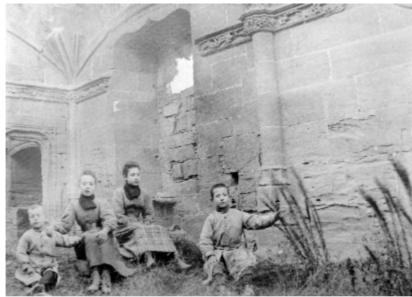
Fotografia de l'Obra de Fluvià, de principis de segle XX. (Història Gràfica de la Segarra)
