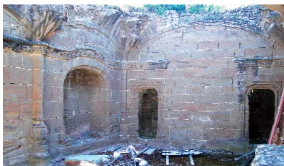
Vista de la paret que tanca la capella per la banda nord de l'any 2004. En aquesta imatge es veu la decoració en traceria de les dues portes i l'estat d'abandonament en què es trobava l'edifici en aquest moment
