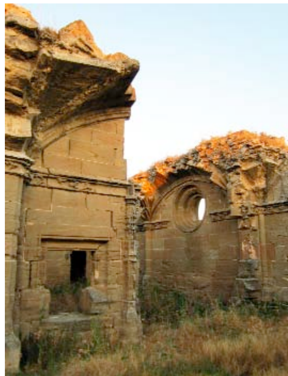
Fotografia actual del vestibul de l'Obra de Fluvià, on es poden apreciar els diferents motius decoratius d'aquesta sala i també de la capella. Cal destacar les traces conservades de l'ornamentació de les diverses comunicacions entre els dos espais
