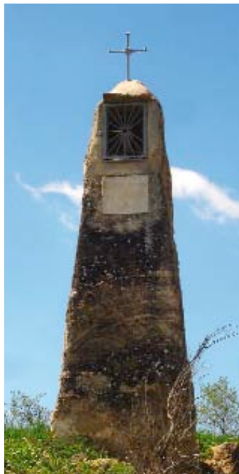
Estat actual del pilaret després d'haver estat restaurat en resposta a les accions vandàliques
