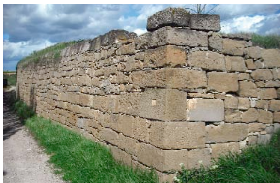
Paret de marge del camí dels Romans, en el seu tram sud
