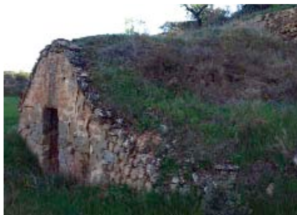
En aquesta fotografia podem veure clarament com les cabanes queden totalment integrades en el paisatge
