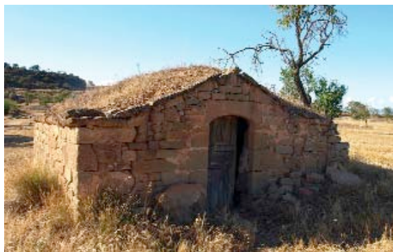
Façana principal de la cabana 5. Com es pot veure, tan sols destaca la pedra que fa de llinda, que presenta forma trapezoïdal i arc escarser
