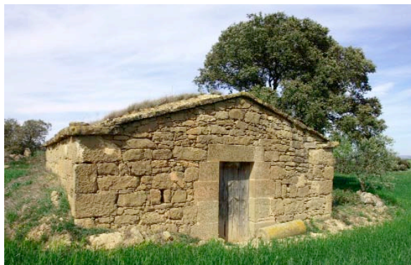
Prototip de cabana de pagès a la Segarra, amb porta amb llinda i pedres ben tallades emmarcant-la i també a les cantonades, ben inserida dins el paisatge i amb la teulada coberta amb vegetació pròpia
