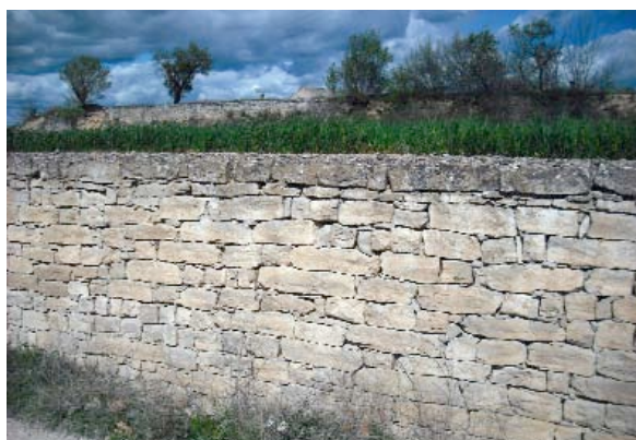
Paret de marge del camí dels Romans, en el seu tram nord
