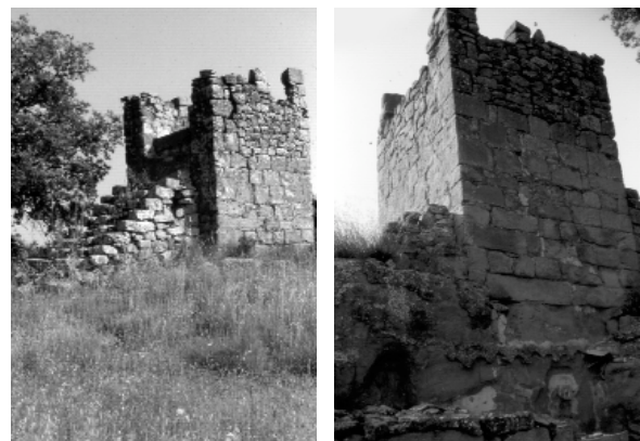
Estructura en superfície: cara oest i escala (esquerra) i cara est i sud amb detall dels desguassos (dreta)
