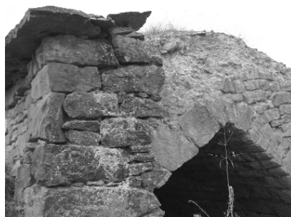
Detall de la volta apuntada i ull de bou a la façana posterior
