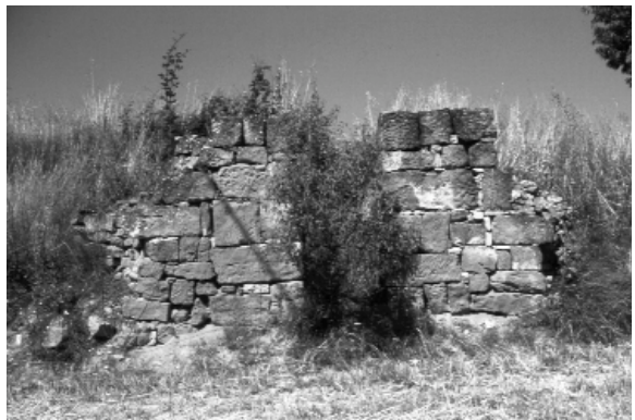
Detall de la façana d'ingrés, mig enderrocada, del forn
