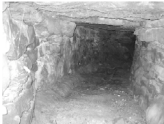
Interior de la "garuta"
