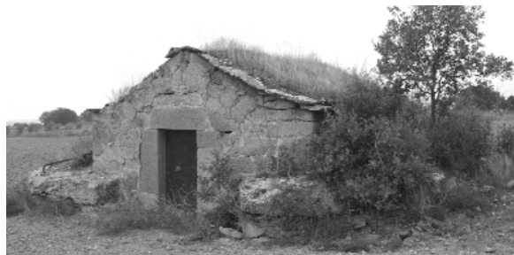
Cantonada sud est de la cabana, amb la façana d'ingrés en primer terme
