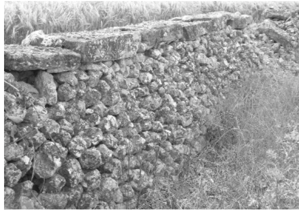
Detall del parament a base d'amuntegament de petites pedres irregulars amb coronació de llosa mitjana que coronen el mur i fan d'escopidor de l'aigua de la puja.
