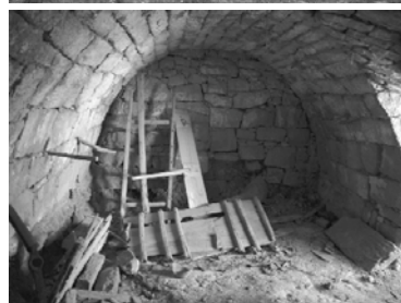
Façana d'ingrés, orientada al sud (foto superior) i interior (foto inferior)
