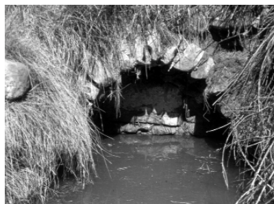
Restes de l'estructura de volta bastida a l'indret de la font en una foto de 1995
