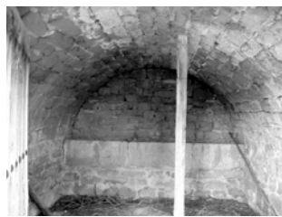
Interior de la cabana amb el detall de la menjadora en el mur nord
