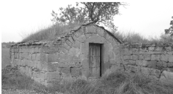
Façanes sud i oest de la cabana
