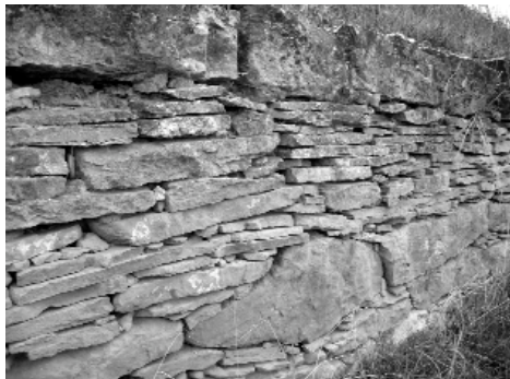
Detall del parament a base de llosetes i coronació amb grans blocs
