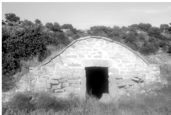
Exterior de la cabana de la volta del Sarri d'alçada. Un ràfec de lloses ressegueix tot el perímetre de la coberta. A l'interior es conserva la menjadora.
