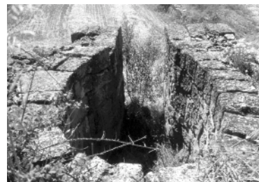
Detall de la planta del forn en forma de ferradura
