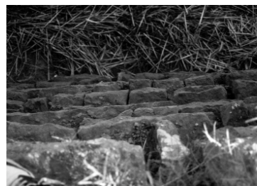
Detall, en planta, de l'esglaonament de la paret de marge
