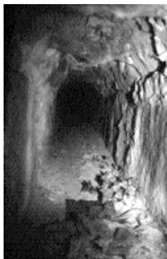
Canalització a la Font de la Vila. Vista del seu interior
