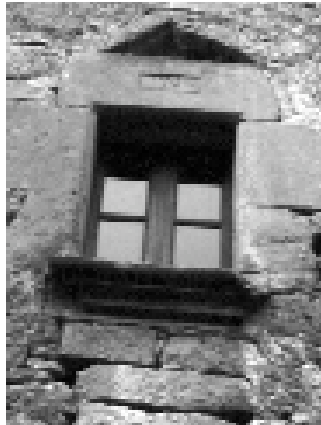
Detall del recurs constructiu en una obertura consistent en dues lloses inclinades formant una descàrrega damunt la llinda
