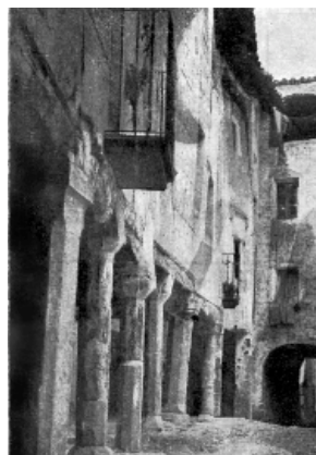
Vista de la porxada de la plaça en una foto de començament de segle
