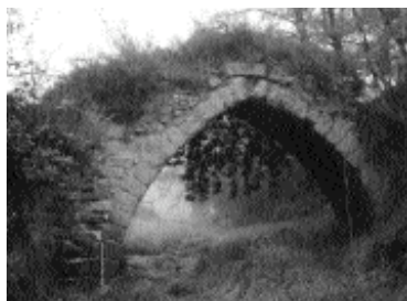
Pontet del diable en una foto de 1999 representa aparell de pedra irregular, sorrenca, rejuntada amb morter.
