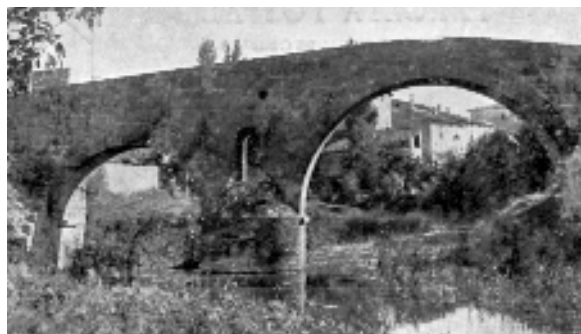
Foto de principi de segle vista des de la façana que mira a llevant (El Pont de les merites. Torà..)
