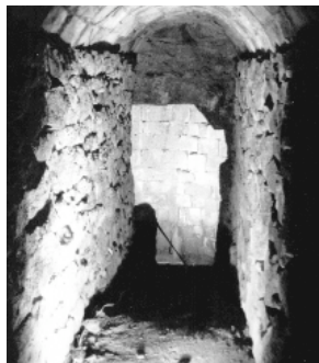
Corredor o galeria d'accés lateral al pou de gel
