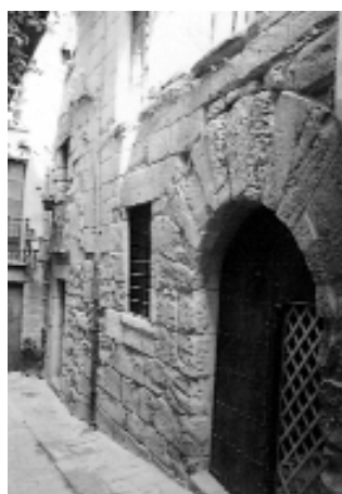
Portal adovellat en una fotografia recent
