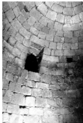
Detall d'una part del mur circumdant amb l'obertura d'ingrés centrada, on arrenca la cúpula en el punt
