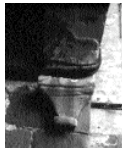
Detall d'una mena de permòdol que documentem al carrer Nou
