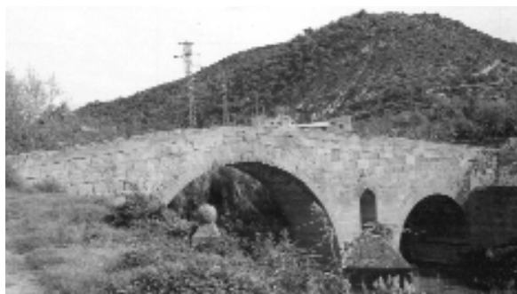
Imatge actual del pont (Foto: Benet Molins)
