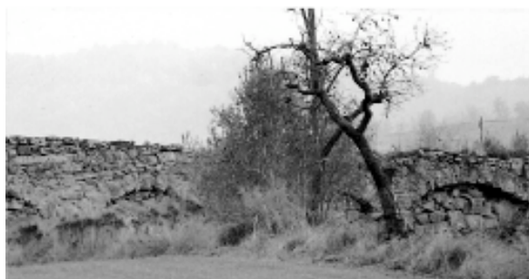
Detall dels arcs cecs que suporten el canaló que conduïa l'aigua al Convent (Història de Torà. Àlbum de fotos...)
