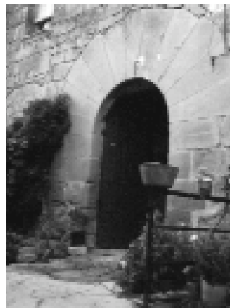
Detall del portal adovellat
