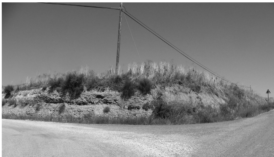
Figura 7. Vista del talús on es localitzà l'estructura amb la tenalla en el seu interior.
