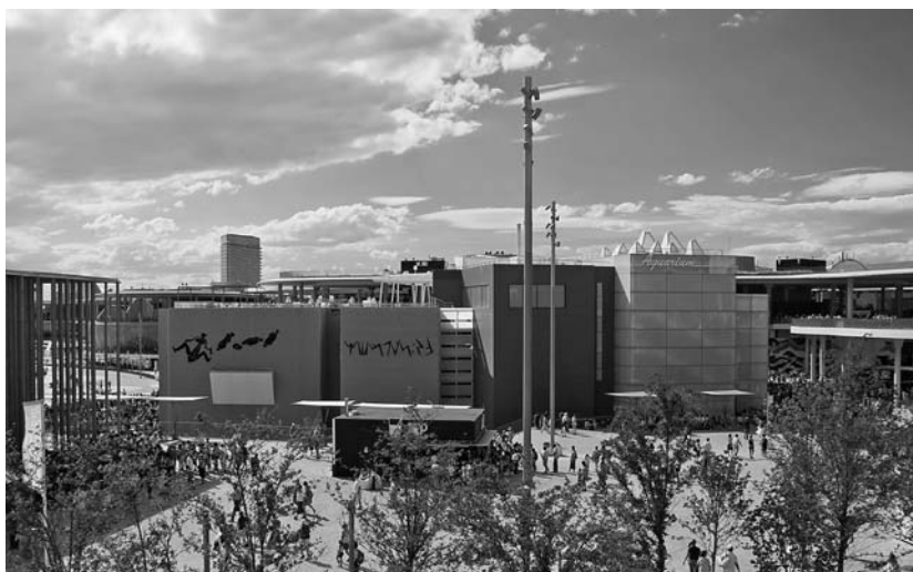
Fig. 7. Exterior del Acuario Fluvial de Zaragoza
