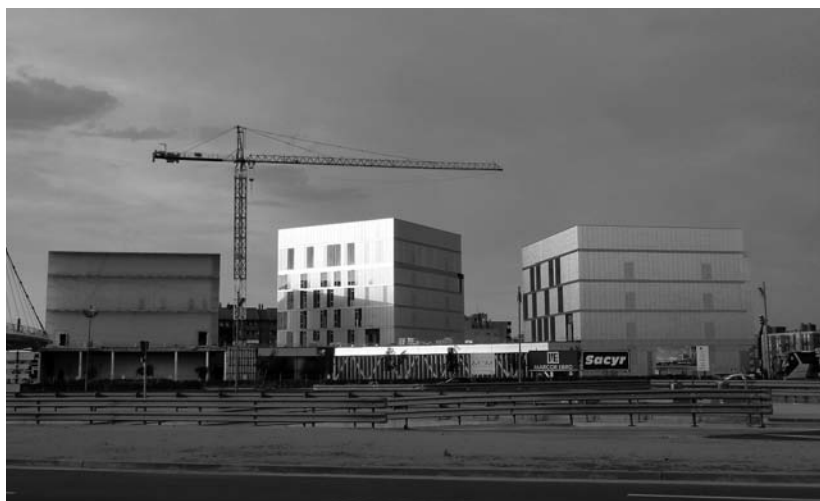
Fig. 10. Centro de Arte y Tecnología de Zaragoza. Estado de las obras en junio del 2011
