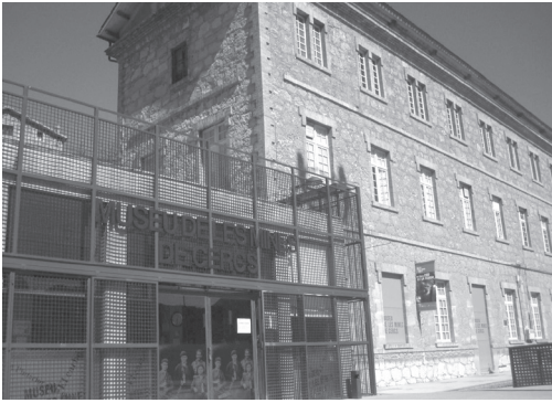
Fig. 1. Entrada al museo y edificio de servicios
