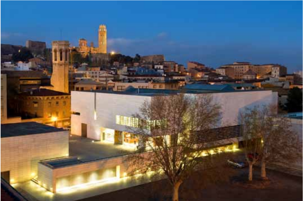
Fig. 3. Edificio del Museu de Lleida
