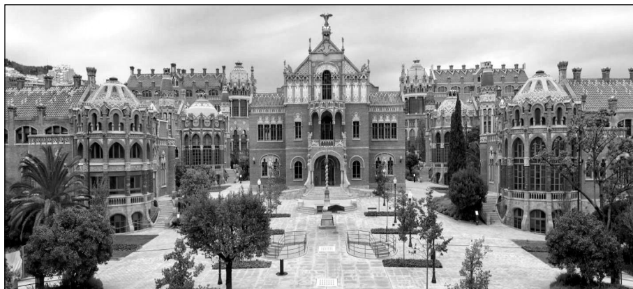
Figura 2. Recinte modernista de l'Hospital de la Santa Creu i Sant Pau.
