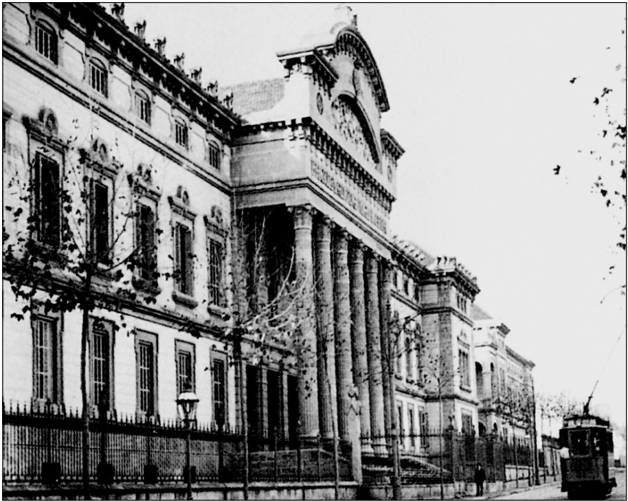
Figura 2. Façana de la nova Facultat de Medicina i Hospital Clínic al carrer de Casanova. (Foto: Arxiu RAMC)
