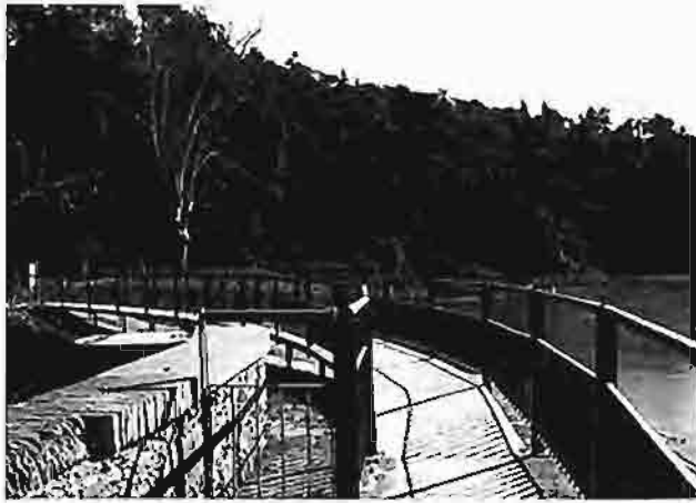
La presa de l'embassament de Vallvidrera
