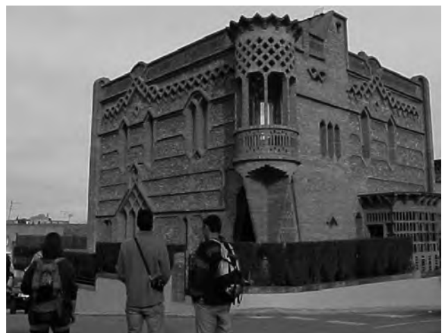
Figura 11. Ca l'Espinal, edifici modernista de la Colònia Güell de Santa Coloma de Cervelló.
