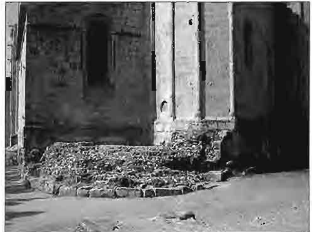
Restes de la fortalesa romana a la base dels absis, on s'observen sis filades de carreus. Els de la torre SE, rere la sagristia, van ser desmuntats i aprofitats en els fonaments d'altres zones de l'església.
