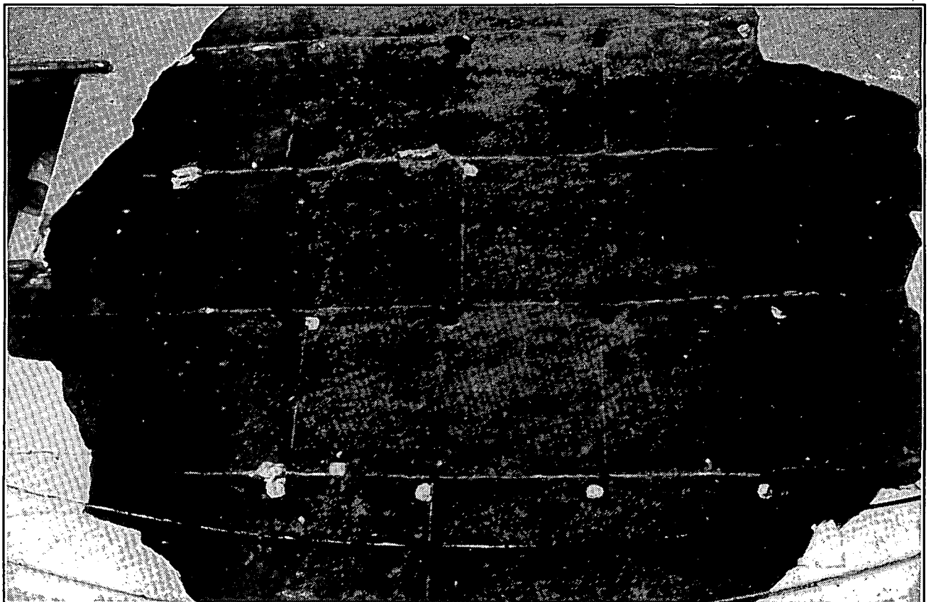
Detall d'una paret de tàpia. S'hi aprecien les juntes de les tapieres i els forats dels llistons.
