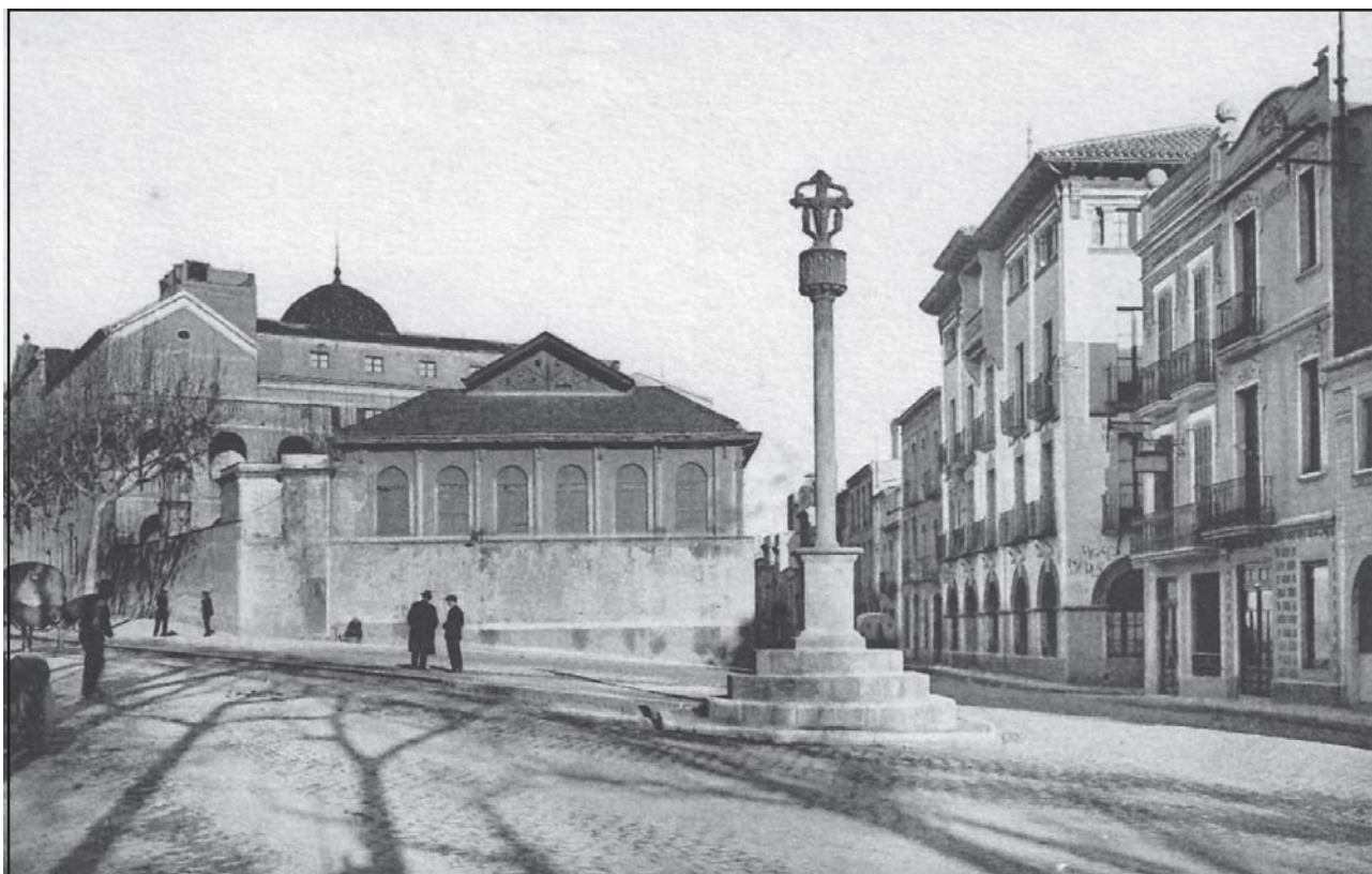
Visió de l'hostal de Montserrat després de les obres de reforma i ampliació de l'any 1925. Ja s'havien enderrocat les cases del carrer de Tras Santa Anna, però encara no s'havia iniciat la construcció del nou portal del pati de Santa Anna.
