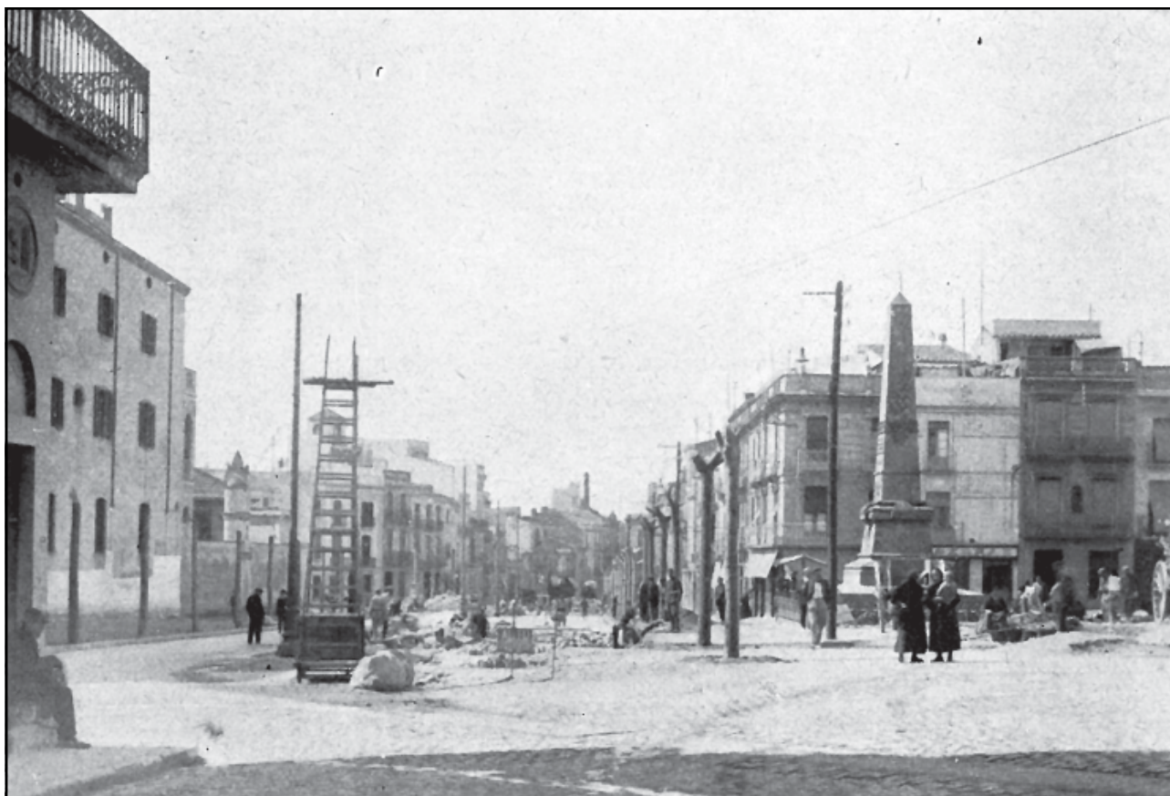
Obres de reforma de la Rambla (1928).
