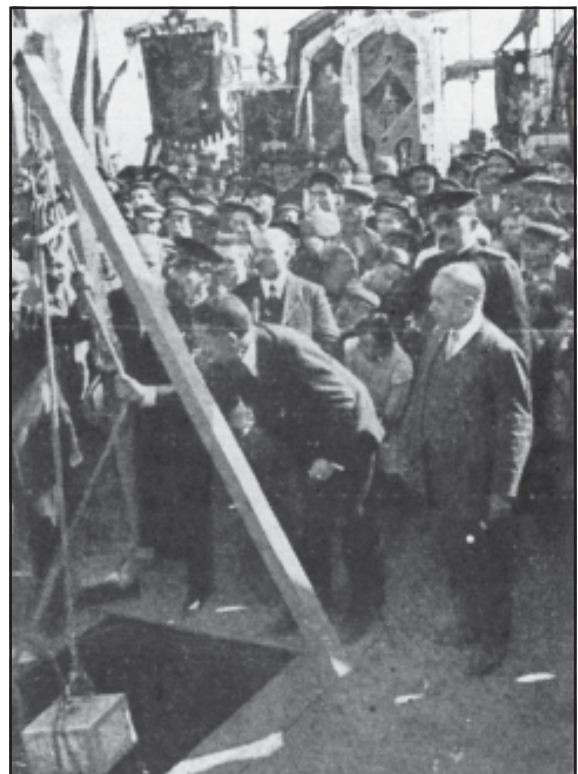
Col·locació de la primera pedra al monument a Miquel Biada l'any 1911. Fotografia extreta de La Actualidad .
