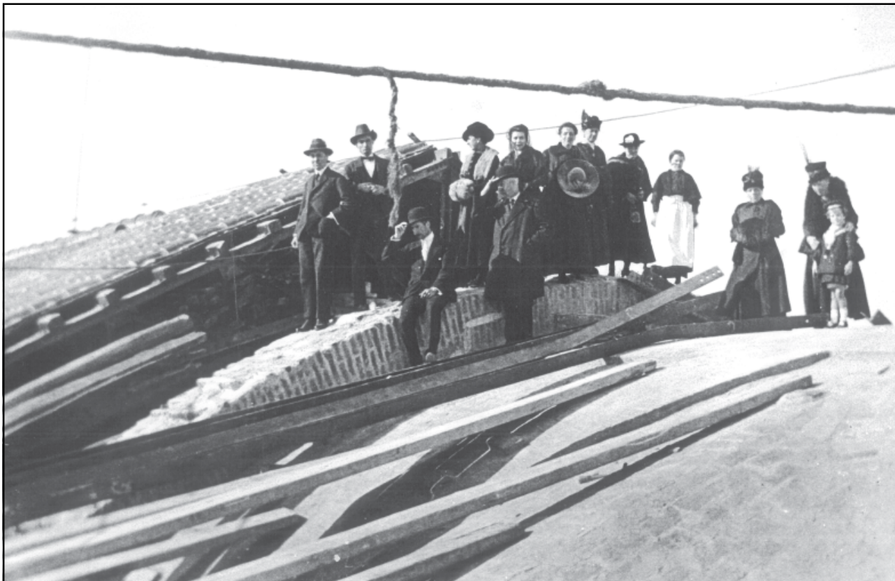
Construcció de la nova estructura de la teulada de la part posterior, des del creuer gran, de la nau de Santa Maria (1917). Visita familiar a les obres. Al centre, amb abric, Josep Puig i Cadafalch, arquitecte de les obres, juntament amb Lluís Gallifa i Grenzner, autor de la fotografia.
