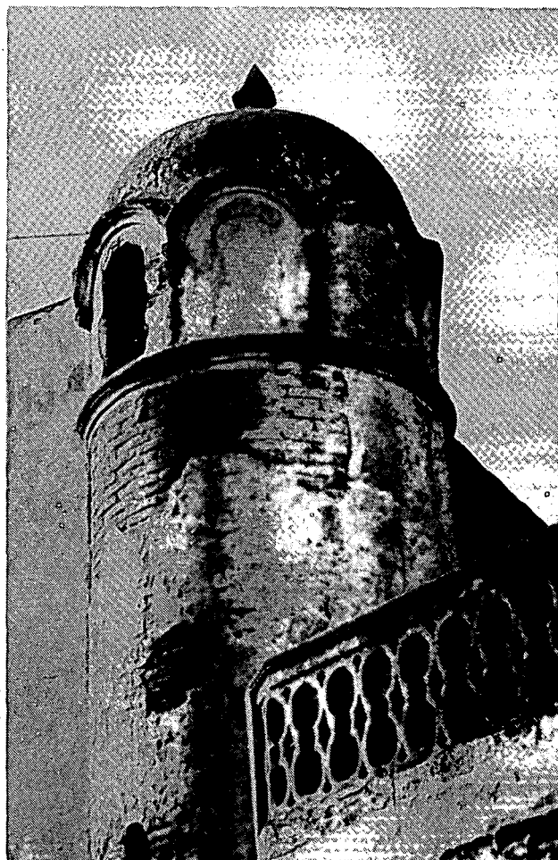
Repartidor de la Companyia d'Aigües. Muralla dels Genovesos. Obra de Jeroni Boada (1865?). Fotografia Agàpit Borràs.
