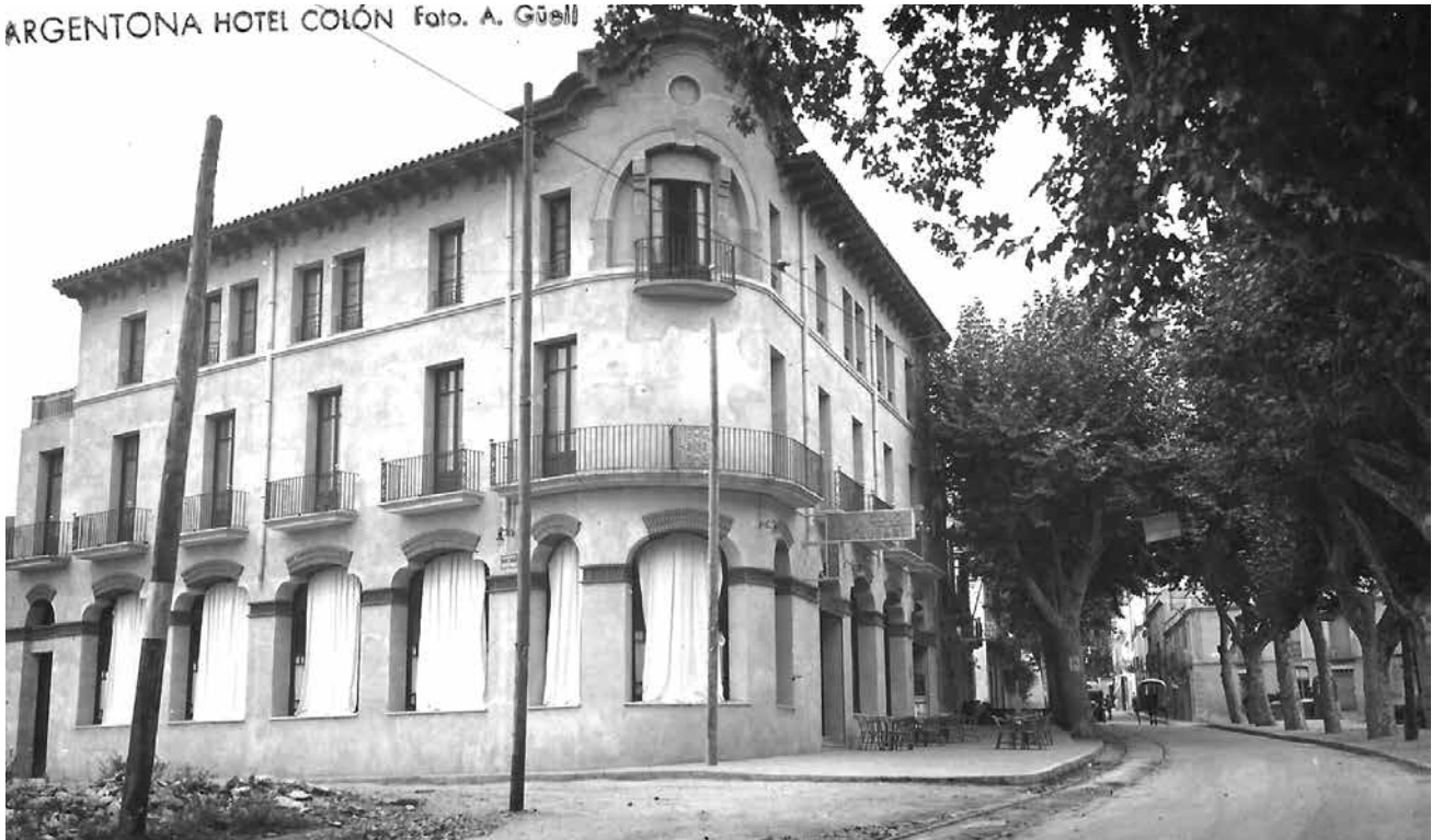
↑ L'Hotel Colón, acabat de construir
