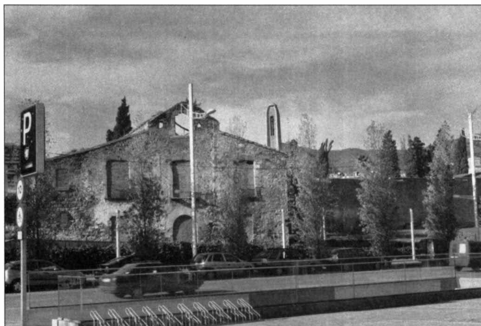
Antiga masia de Can Valent, actualment en un lamentable estat de conservació. Vista des de l'altra banda del carrer de Piferrer. Fotografia cedida per l'Arxiu Històric de Roquetes-Nou Barris.
