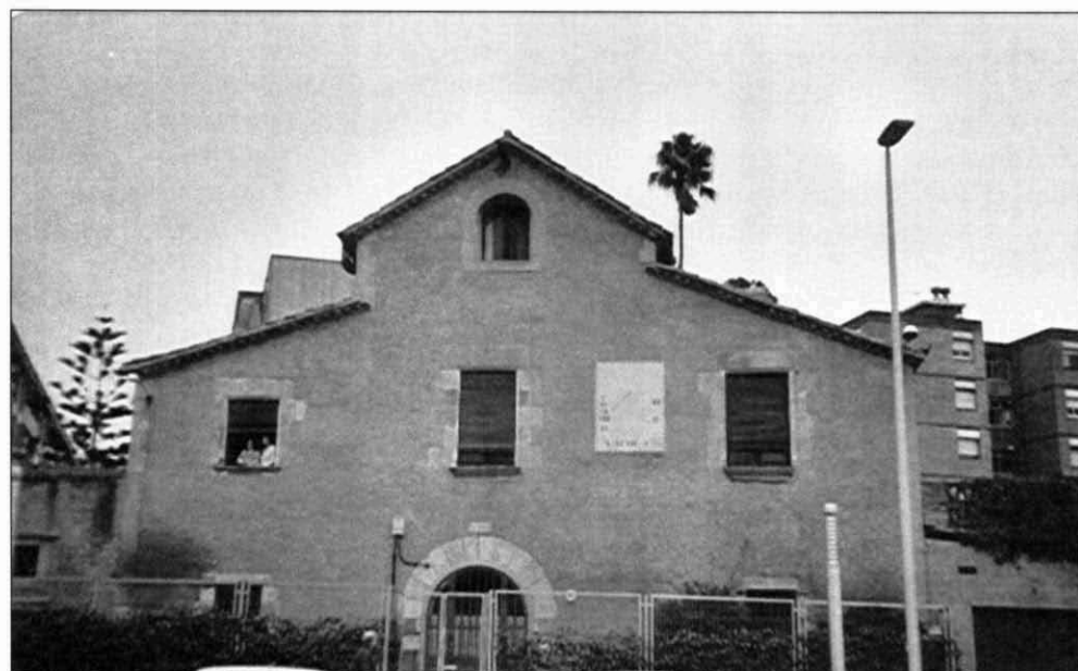
Can Verdager és la masia més ben conservada de Nou Barris. Vista des de l'altra banda del carrer de Piferrer. Fotografia cedida per l'Arxiu Històric de Roquetes-Nou Barris.
