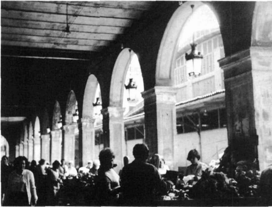
Voltes de la Plaça Mercadal, dissenyada per l'arquitecte Mas i Vila. Procedència: Arxíu Municipal del Districte de Sant Andreu.
