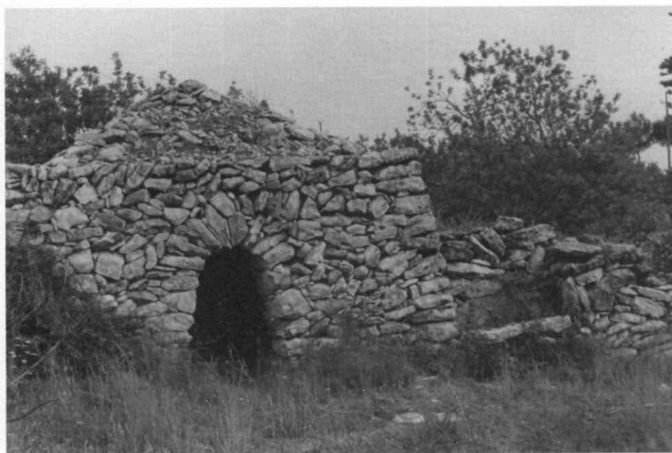
Les pedres angulars, sempre tenen certa inclinació, el seient guarneix el lloc, i és de notar la cúpula coberta de pedra terra i vegetació. La barraca la trobem cap a la Trabala a mas Boada i anant a La Riera.
