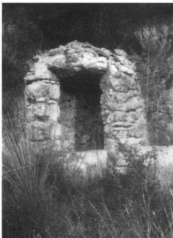
Una de les cisternes abans d'arribar a la Sucarrada. La part sortint és obrada en pedra seca. I és prop la bassa del cantell.
