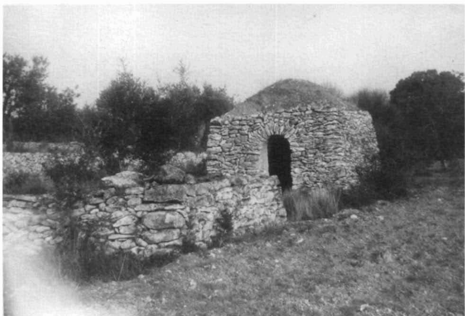
Simplicitat constructiva i bellesa de barraca amb cúpula vegetal en el camí que va a mas Boada, i fa via a Cantacorps.
