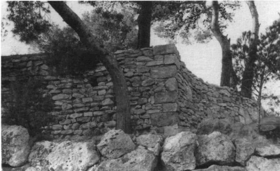
La pedra en sec és omnipresent a la totalitat del terme. Angle Est del que va ser Castell de Montornès. Les pedres obrades estaven escampades en aquell indret. Amb diversos companys vam fer plegats la petita reconstrucció. Era necessària per les representacions del Pessebre Vivent. En el desnivell que allí existeix, el pessebrista Josep M. Guivernau i Porta col·locà les grans pedres, tot eixamplant un camí.
