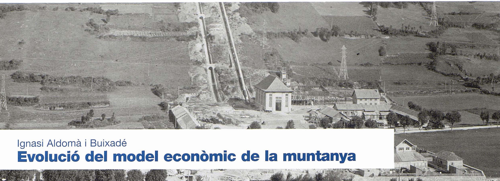
Central hidroelèctrica. E. Solanes
