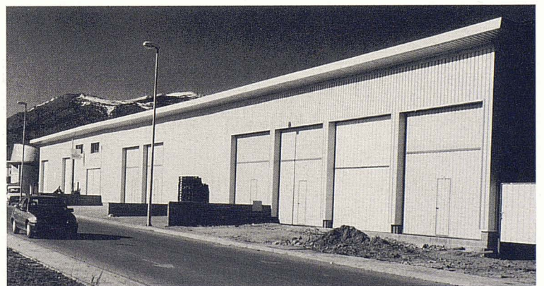
Polígon industrial L'estació a Puigcerdà (Cerdanya)
