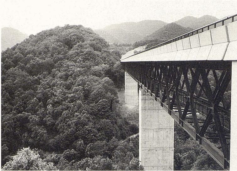
Els viaductes del sot de l'Ullastre i del sot del Pla Perer, de 242 m i 200 m de longitud respectivament, són dues obres molt clàssiques dins de la tradició de l'arquitectura del ferro.
