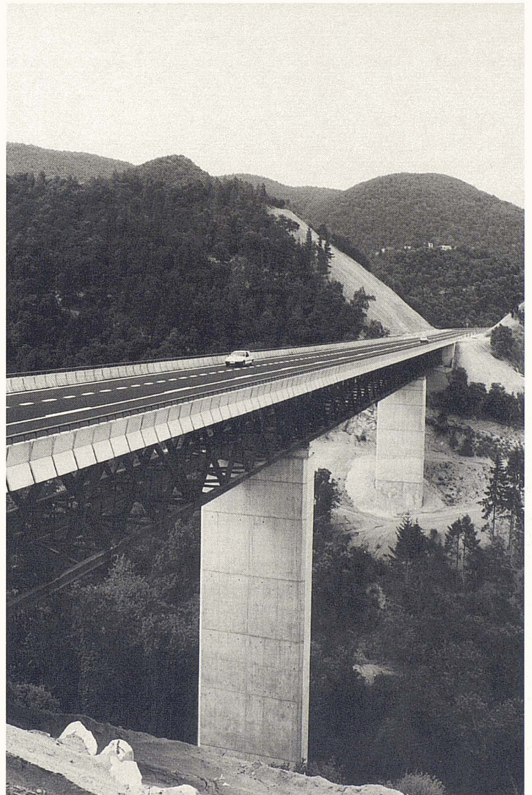
Gràcies al sistema utilitzat per al muntatge dels viaductes, amb dos semiponts que es van llençar des d'una banda i de l'altra de les barrancades, es va poder preservar el fons de les rieres
