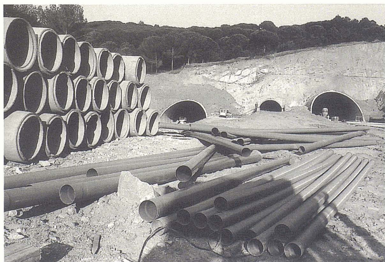
Els túnels de Parpers estan constituïts per dos túnels bessons units, cada 300-400 m, per galeries de comunicació
