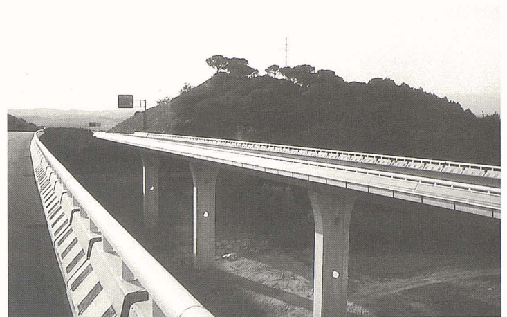
Els viaductes augmenten la permeabilitat de l'obra i, per tant, disminueixen l'impacte sobre la fauna, i també l'impacte social
