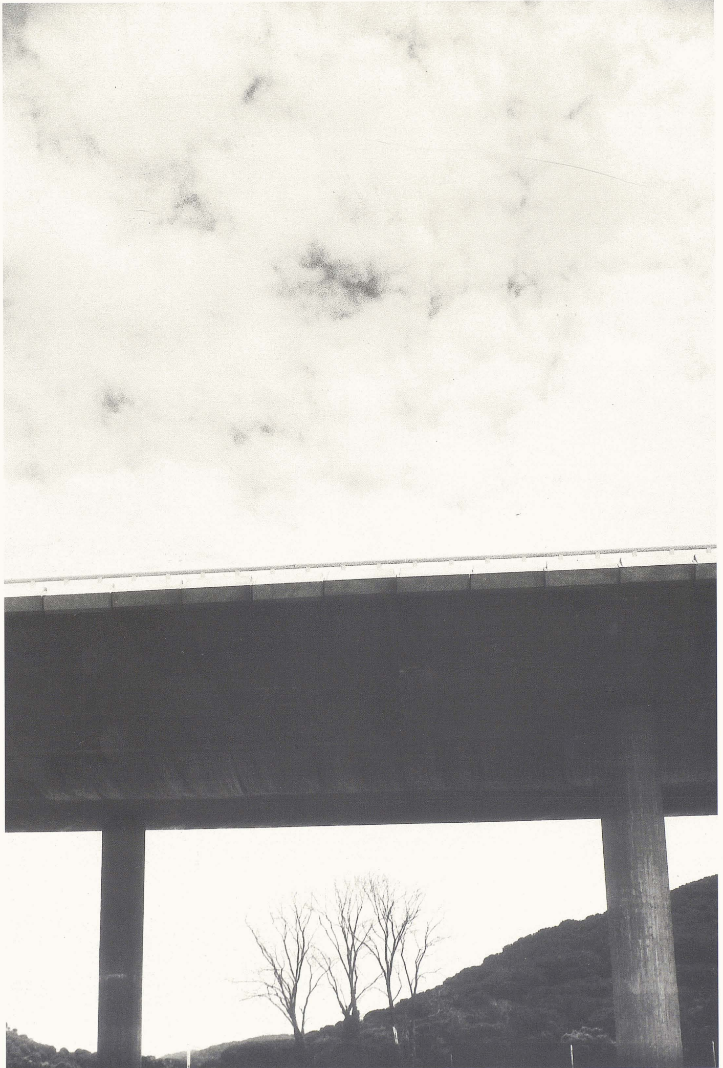
El viaducte d'Argentona, amb una longitud de 275 metres, és una de les obres de fàbrica més significatives del quart tram de l'autopista
