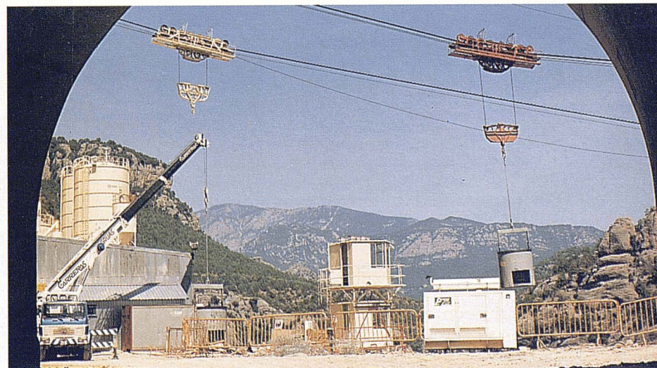
Fotografia 11: Carro mòbil i cubilot del blondin.
