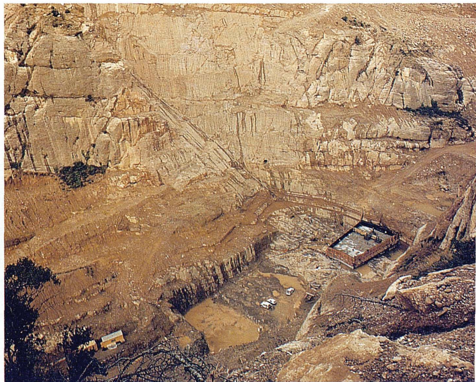
Fotografia 14: Inici del formigonatge l'agost de 1993.
