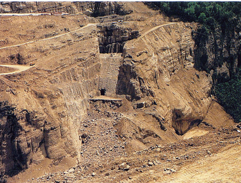
Fotografia 4: Realització de l'excavació dels fonaments al marge esquerre.
