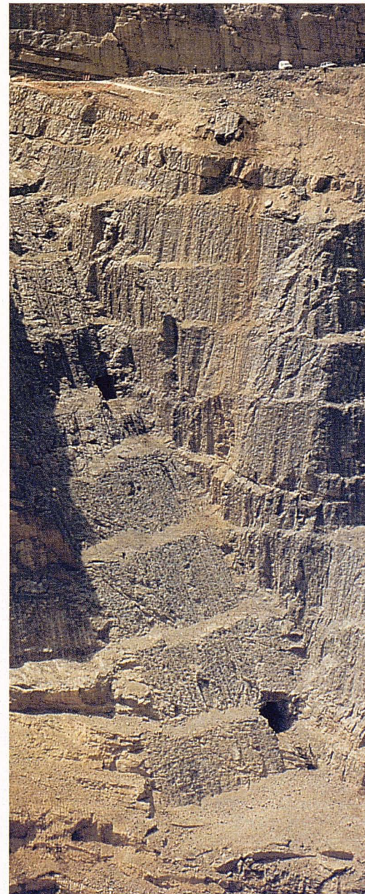
Fotografia 5: Excavació acabada al marge dret. Les dues galeries excavades són prolongació d'unes altres existents al cos de la presa.
