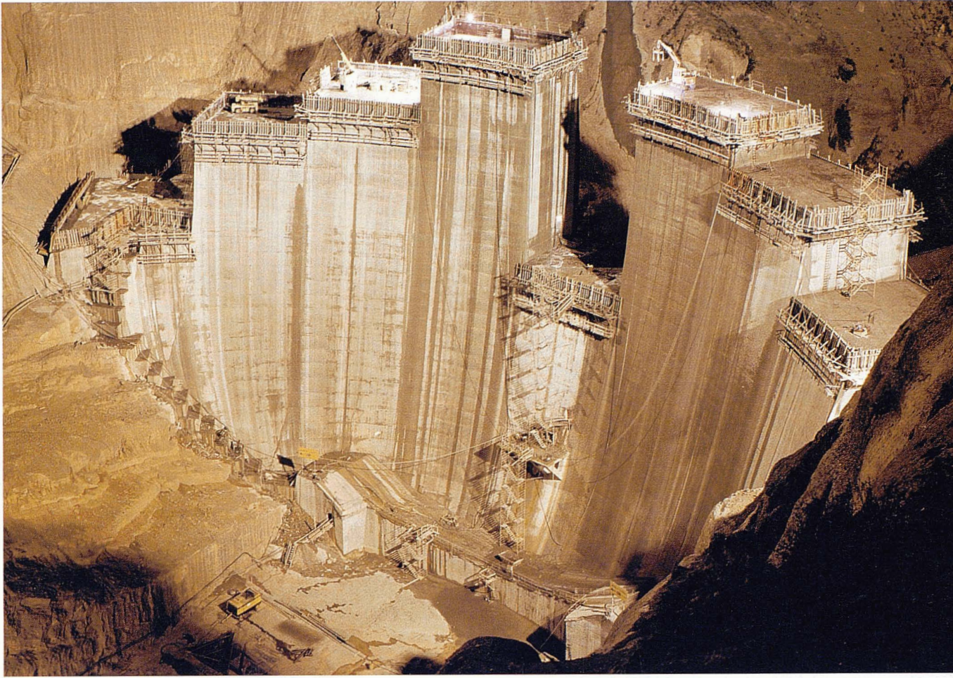
Fotografia 16: Estat actual del formigonatge de la presa.
