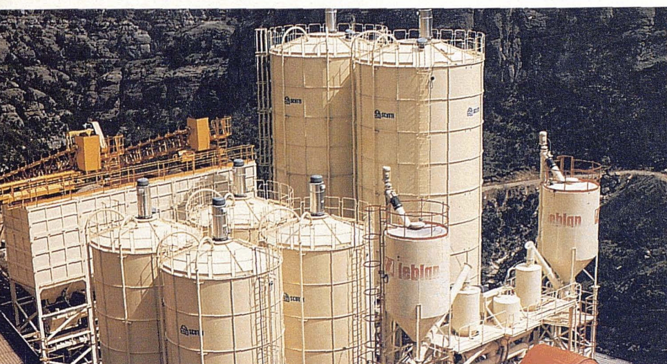
Fotografia 8: Planta de formigó sobre la vall.
