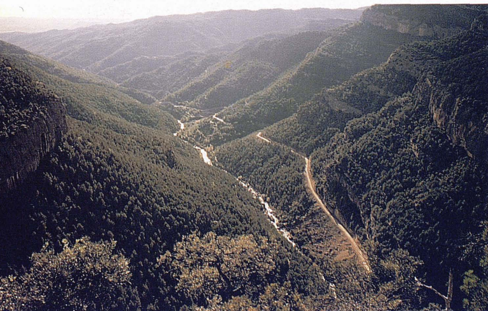
Fotografia 3: Perspectiva del riu aigua avall de la presa. És notable el canvi de morfologia del terreny.
