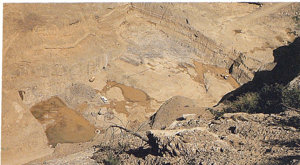
Fotografia 6: Excavació acabada del fons de la presa i toll esmorteïdor.
