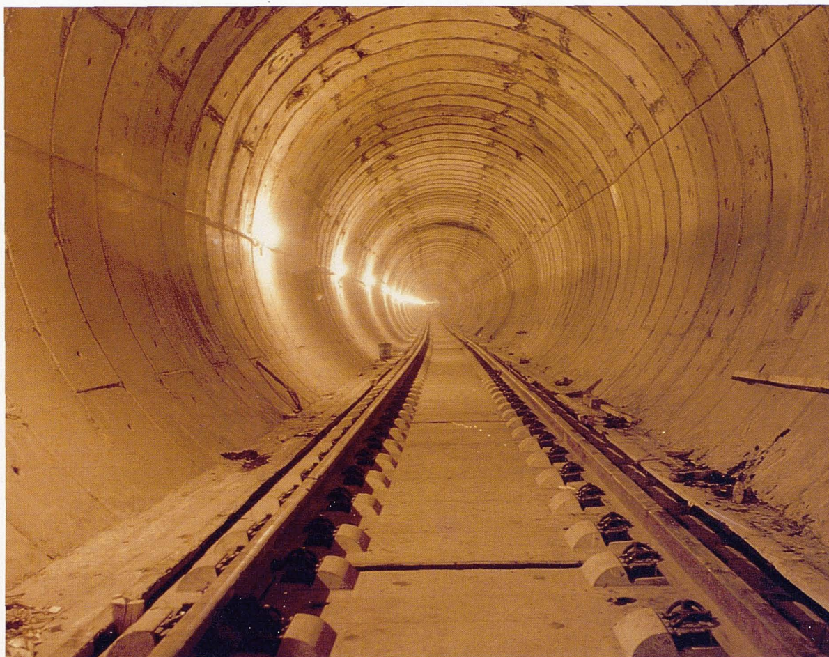
Túnel de la línia 2.
