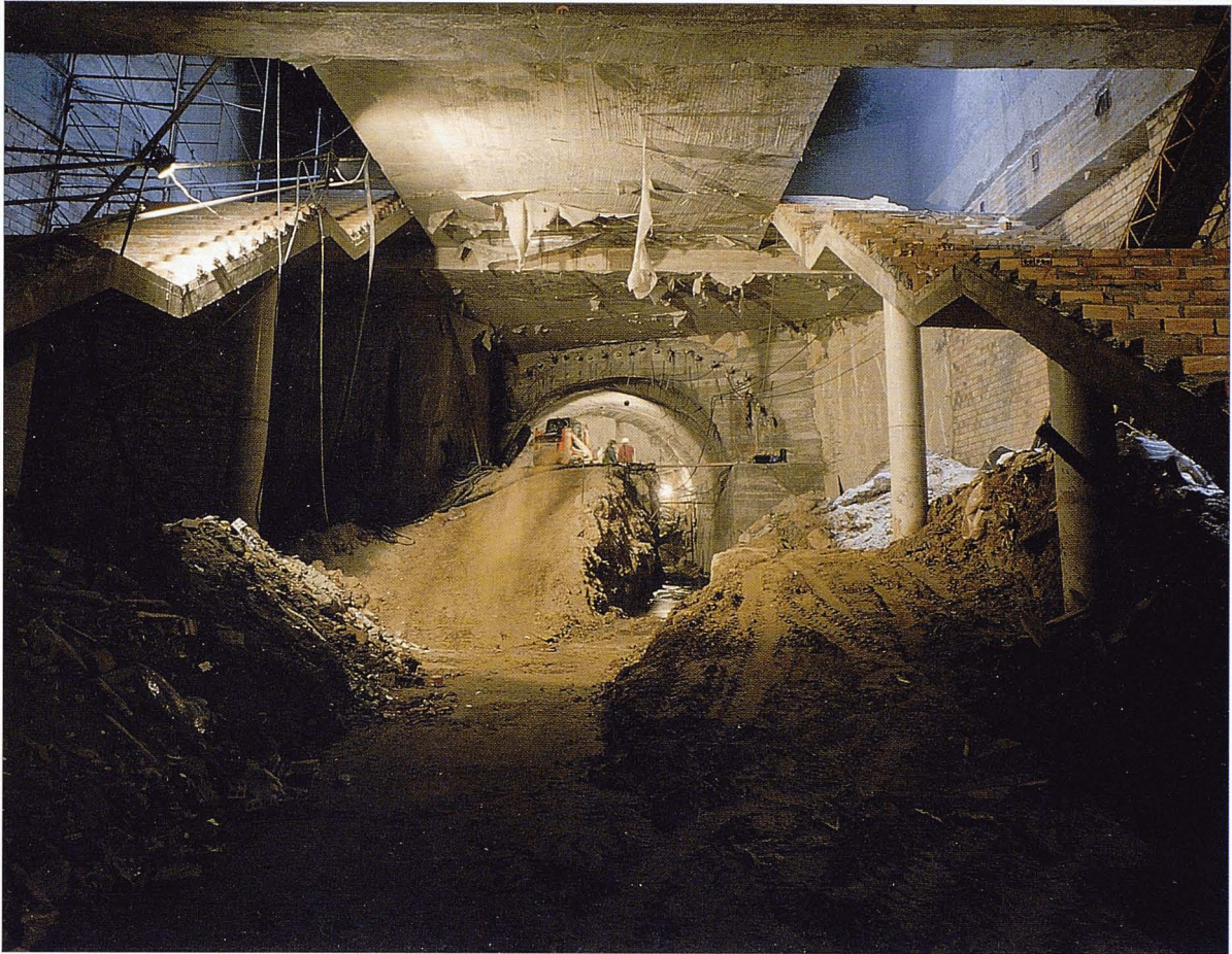
Línia 2. Construcció a l'estació Sagrada Família.
