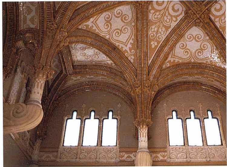
Detall de la cúpula de l'escala principal del pavelló d'administració decorada amb mosaic, ceràmica i vitrall.
