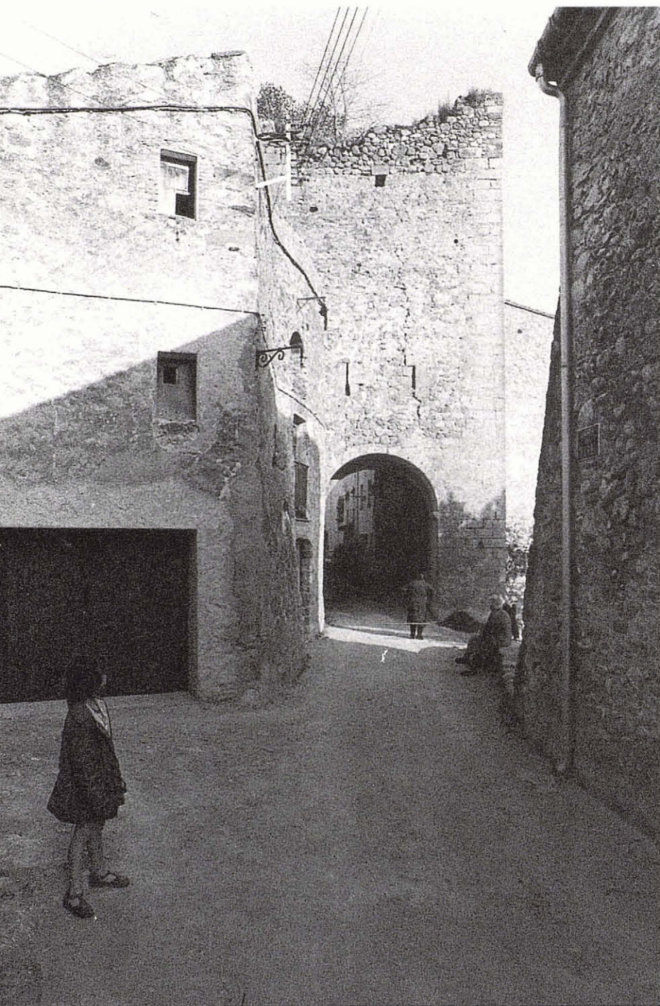
El portal de Dalt i la seva torre vistos del camí d'Albanyà estant, per la part de fora Abans de la intervenció
