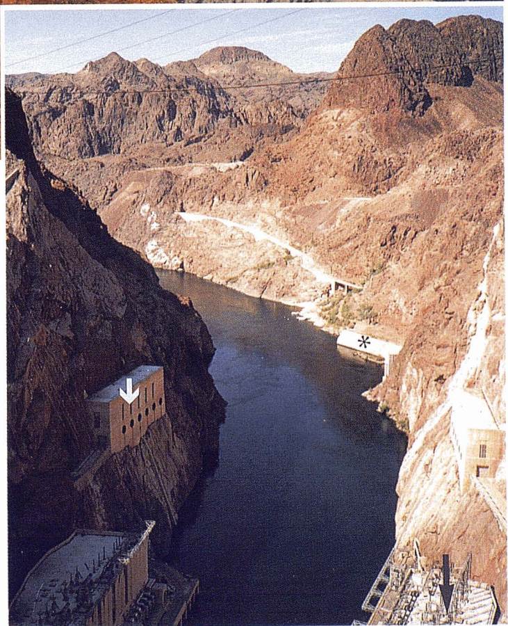
4 Boulder Canyon. Aigües avall de la presa Hoover. Podem observar la central (fletxa llarga), la sortida dels desguassos intermedis (fletxa curta), i la sortida del túnel del sobreexidor de superfície (asterisc).
