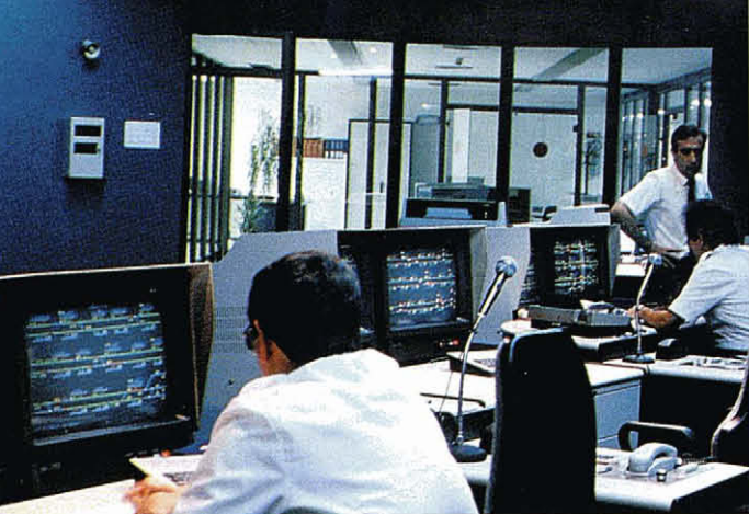
Control de Tràfic Centralitzat (CTC) del Metro de Barcelona.
