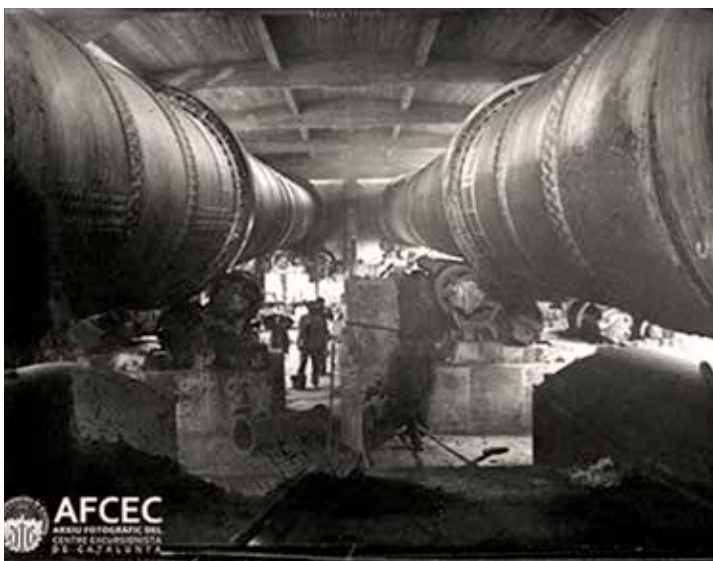
Imatgers de l'interior de la fàbrica de ciment.
