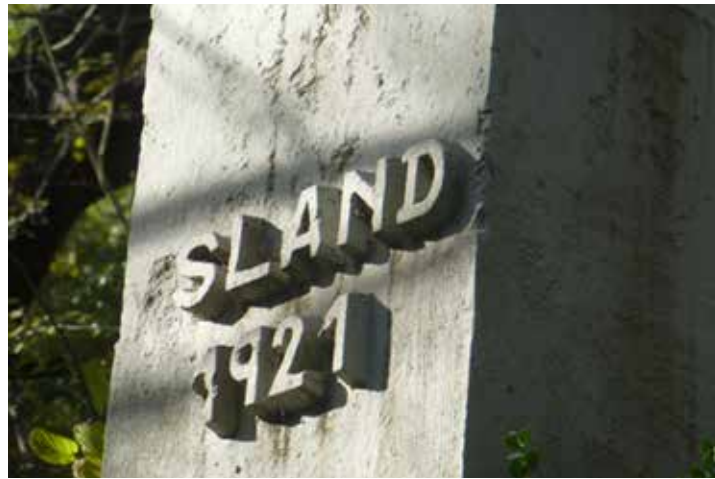
Un dels suports de la canonada al seu pas pel Torrent de Monell. (J.C. ALAYO).
