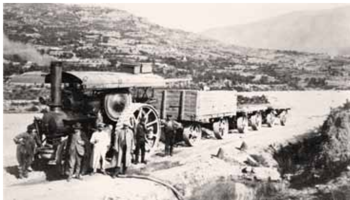
Tractor John Fowler arrossegant dos remolcs camí de Tremp, i aturat per carregar aigua per la caldera en un barranc a prop de Guardia de Noguera. Al fons es divisa la serra del Montsec de Rúbies i el poble de Llimiana. A la foto es veuen els tres conductors /fogoner /ajudant del tractor i dos enginyers/administratius de RFE amb un xofer (vestit de blanc). A la foto, ens falta el cotxe que els transportava.
