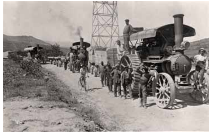
Tres tractors John Fowler, possiblement als entorns del avui, embassament de Cellers, baixant cap a Balaguer.
