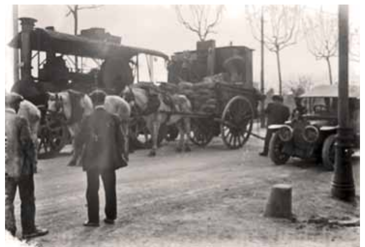
Locomòbil John Fowler, amb una carrega de transformador, no sabem pas on, camí del Pallars.
