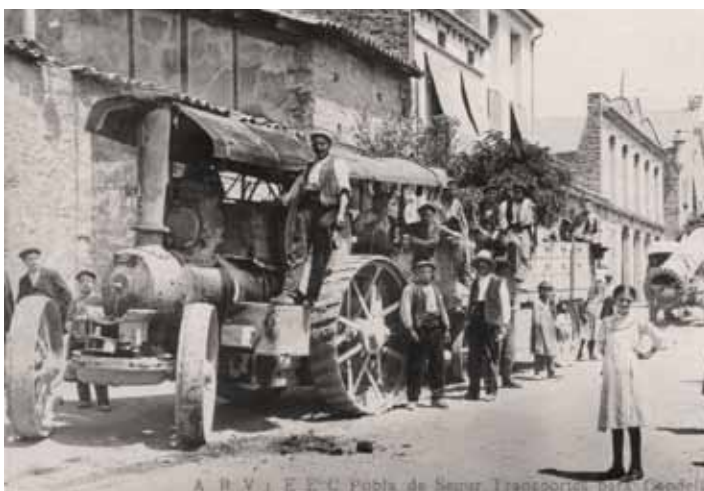
Tractor Mc Laren de la EEC a la Pobla de Segur, camí de la Vall Fosca. Al fons hi ha un remolc carregat amb un tram de la canonada de pressió de la central de Capdella. Tota la canalla del poble guaitant ... Hi ha una pel·lícula on es veu aquesta mateixa imatge i com, manualment, enganxen el remolc de la canonada al locomòbil.
