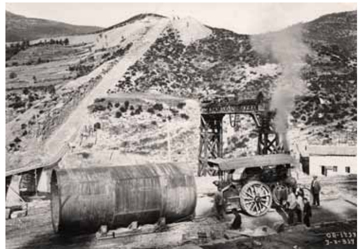
Un locomòbil John Fowler arrossegant un tram de canonada de força a l'explanada davant la central de Seira de Catalana de Gas.
