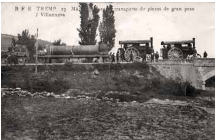
Transport amb doble tracció amb 2 tractors John Fowler, arrossegant una virolla de la fàbrica de ciment de Susterris.
