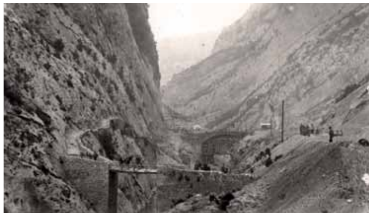
Construcció d'un pont.
