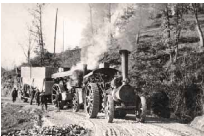
Un comboi doble tracció de EEC amb un Mc Laren al davant i un John Fowler al darrera, a la Plana de Montrós, camí de les obres de la central de Capdella. Arxiu Manel Gimeno.
