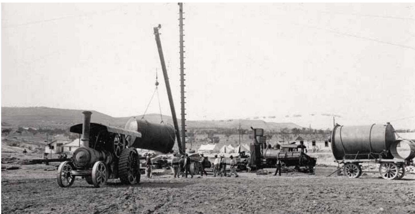
Conjunt d'un tractor John Fowler, una locomotora Porter, una grua tipus Derrick i remolc.
