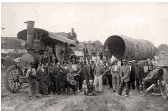
Tractor John Fowler arrossegant un remolc amb un tros de la canonada de pressió de la central de Talarn en un lloc desconegut. (ARXIU FONTS HISTÒRIC ENDESA)
