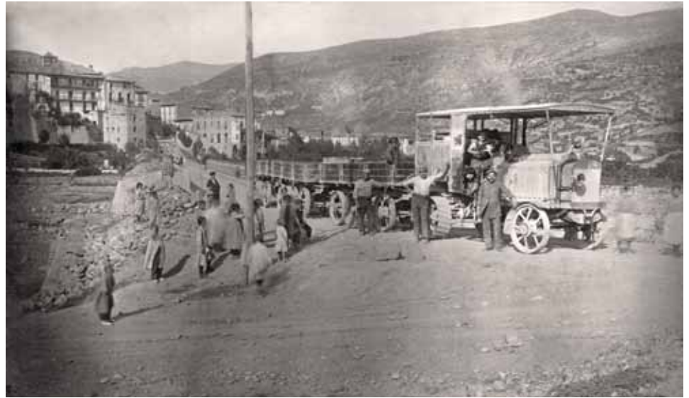
Un Tren Renard – Daimler, original, amb 3 remolcs Renard al pont d'entrada de la Pobla de Segur.
