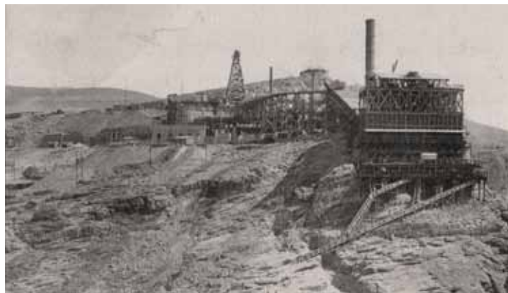
Vista general de la Fca de Ciment de Sant Antoni. POSTAL D'ATV
